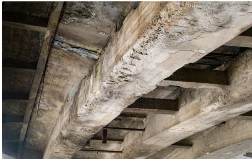
Sie kommt schleichend und bleibt oft lange unbemerkt, bis es zu spät ist: Korrosion. Im Bild der verwitterte Unterbau einer stahlbewehrten Betonbrücke.
