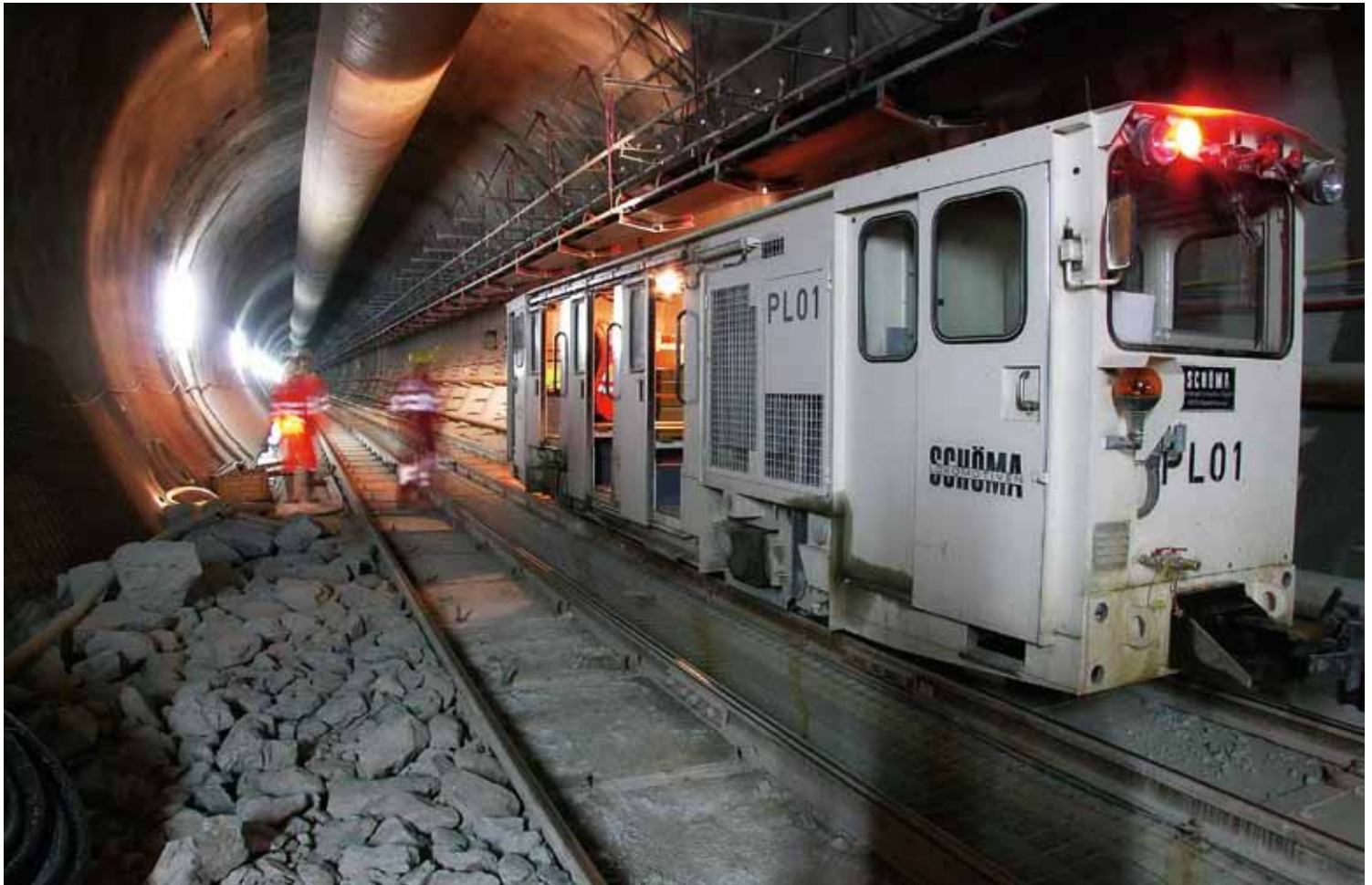
Mit der Stollenbahn fahren die Mineure bis zu eine Stunde lang tief in den Berg hinein; bis nahe an die Stelle heran, wo am 15. Oktober der Durchstich der Gotthard-Oströhre stattfinden soll. (Bild: AlpTransit Gotthard AG)
