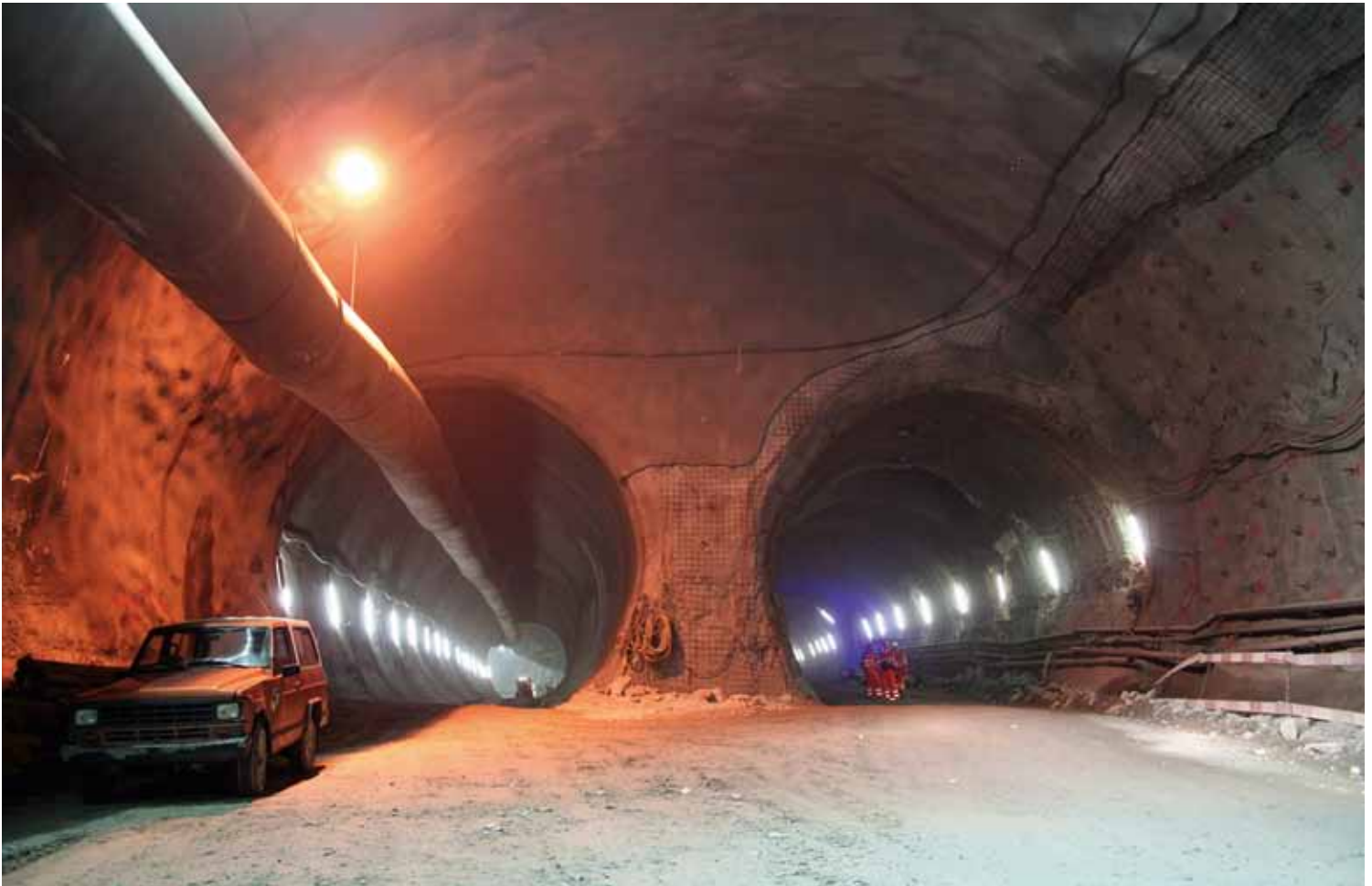
Der längste Eisenbahntunnel der Welt: Ab 2017 sollen nach Einbau der Eisenbahntechnik die ersten Züge durch die beiden 57 Kilometer langen Tunnelröhren von Bodio im Tessin nach Erstfeld in Uri rollen. (Bild: AlpTransit Gotthard AG)
